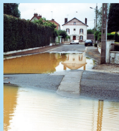
Inondation de Noyon (60)
